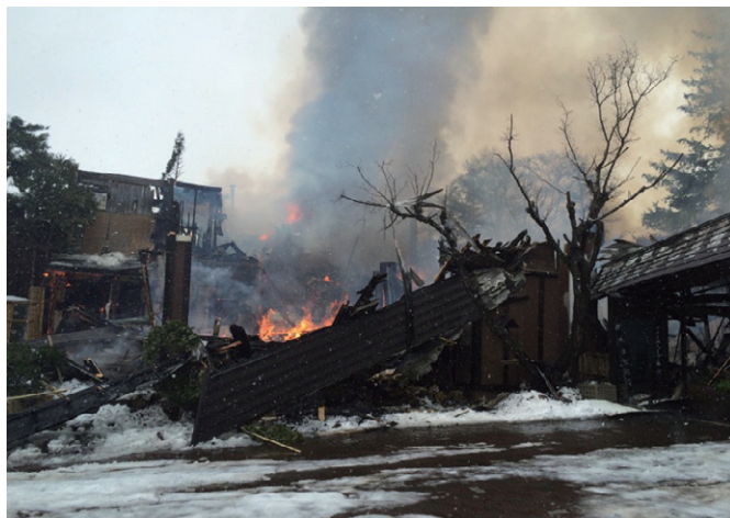
火災により倒壊した建物（平成26年12月4日）
